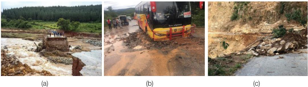
Figure19: Destruction de la route après le cyclone Idai au Zimbabwe en 2019 (a) pont emporté (b) destruction de la route et (c) ramollissement de la surface de la route
