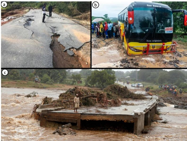
**Figure 22. Destruction des routes causée par le Cyclone Idai (2019) dans les hauts plateaux de l'est du Zimbabwe. (a) route endommagée (b) surface de la route ramollie entraînant l'enfoncement des bus et (c) pont emporté par les eaux.**
