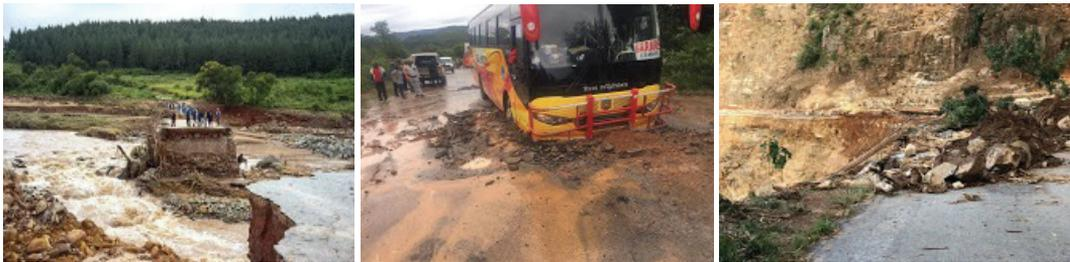
**Figure 19: Destruction de la route après le cyclone Idai au Zimbabwe en 2019 (a) pont emporté (b) destruction de la route et (c) ramollissement de la surface de la route**
