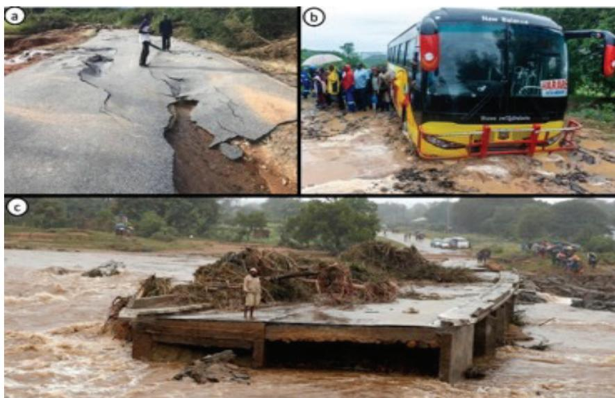
**Figure 13. Destruction des routes par le cyclone Idai (2019) dans l'est du Zimbabwe : (a) route endommagée (b) surface de la route ramollie entraînant l'enfoncement des bus (c) pont emporté par les eaux.**
